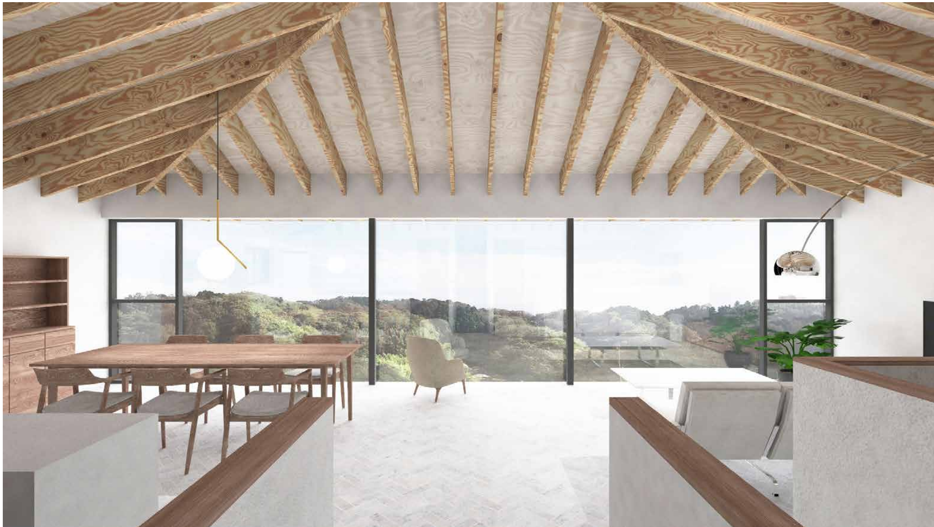
2階LDKの風景。眼下に北鎌倉の六国見山のパノラマビューが広がる。強固な屋根梁によって柱をなくし、柱で途切れてしまうことのない連続的な水平窓をつくる（構造計算による）。また登り梁によってLDK内には極力柱をおとさない大きなワンルームとする（構造計算による）。
